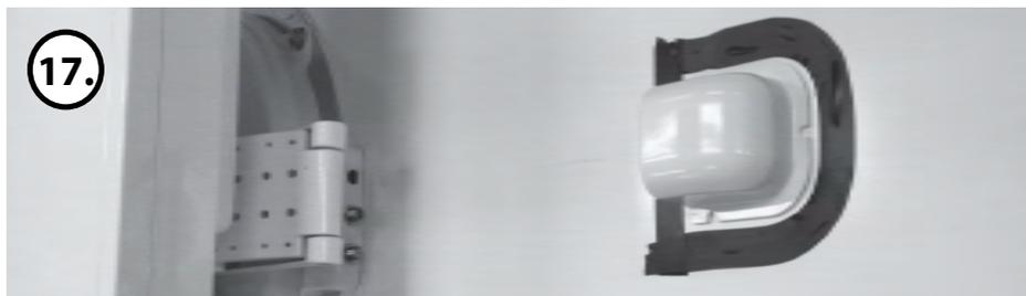
Positionieren Sie die Dachdurchführung mittig zur Antenne mit einem Abstand von ca. 30 cm und bringen Sie das Isolierband mit ca. 4 mm Abstand an.
