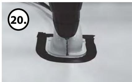
Legen Sie die Dachdurchführung auf und bohren Sie die Löcher mit einem 2 mm Bohrer.
