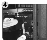
Der Flüssigkeitsstand wird sich verringern, nachdem das System eingeschaltet wurde; füllen Sie bitte weiter Kühlmittel ein, bis der Tank voll ist.
