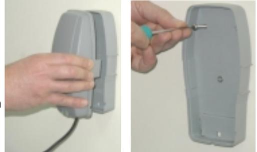
Montieren Sie den Schalter durch die drei Schraubenlöcher in der Haube
