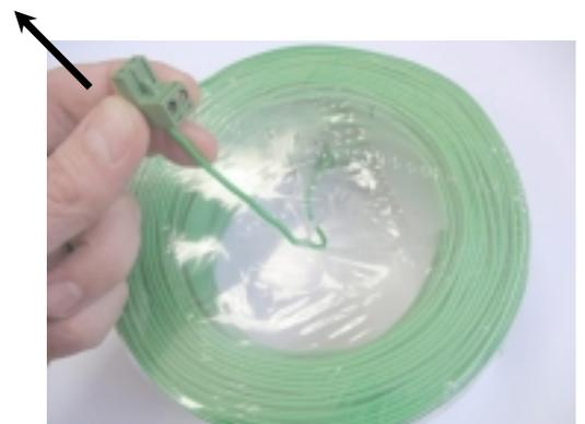
**Bild 1.10** – Ziehen Sie das Kabel aus der Plastikverpackung – entfernen Sie nicht die Verpackung; sie ist als Kabelspender entworfen.
